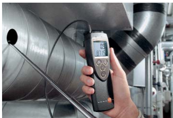
testo 425 při zjišťování objemového průtoku odsávaného vzduchu
